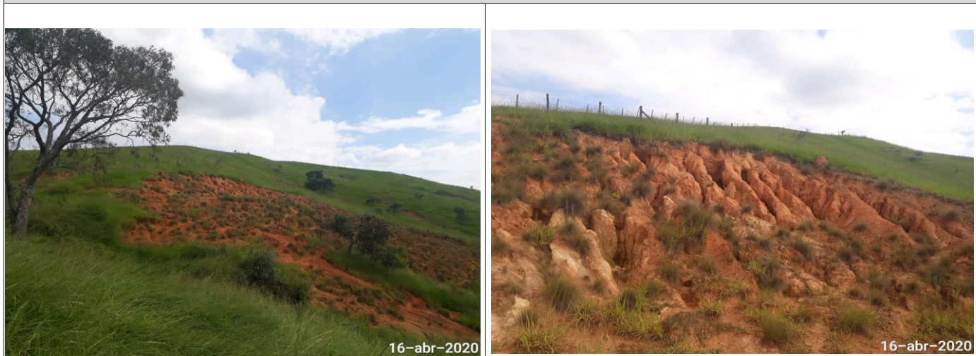
Foto 01 Vista geral da feições erosivas. Foto 02 Vista detalhada da área erodida.
