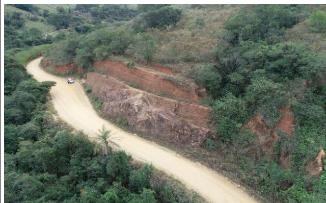
Foto 01 Vista aérea do talude no sentido leste-oeste.
