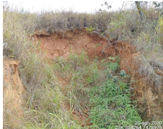
Foto 02 Detalhe da área erodida já com a vegetação cobrindo o passivo.
