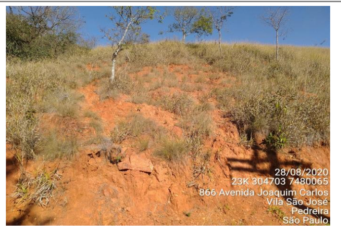
Foto 02 Solo se desprendendo do talude devido a falta de sustentação.
