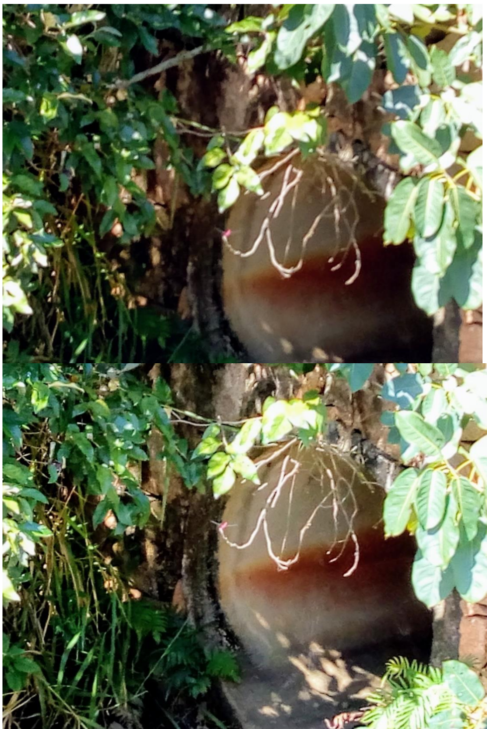
Fotos 01 e 02: Tubulação de saída do ponto P07 seca, na décima campanha.
