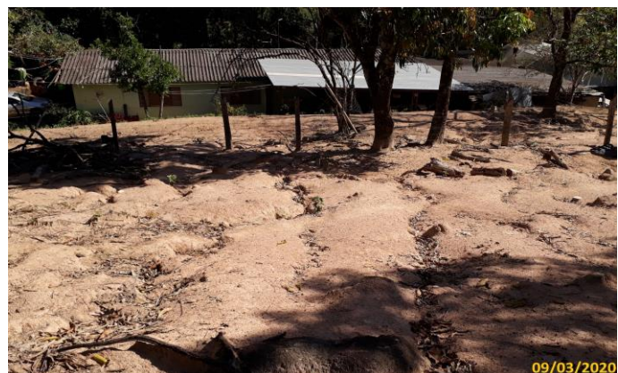
Foto 02 Detalhe do processo erosivo
