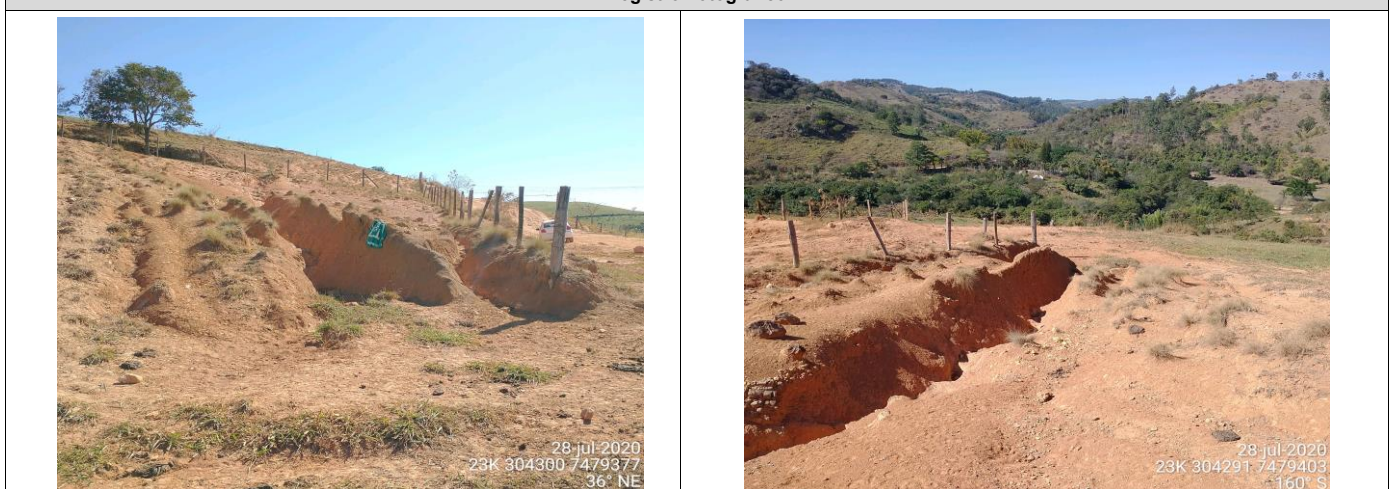
Foto 01 Vista geral da área com presença de sulcos/ravinas. Foto 02 Vista da ravina na orientação sul.
