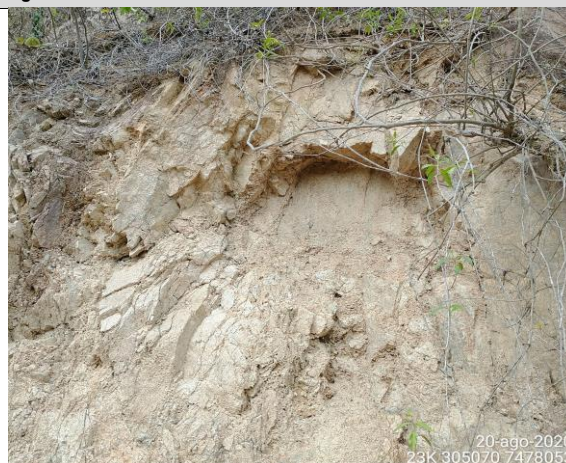
Foto 02 Detalhe do deslocamento rochoso.
